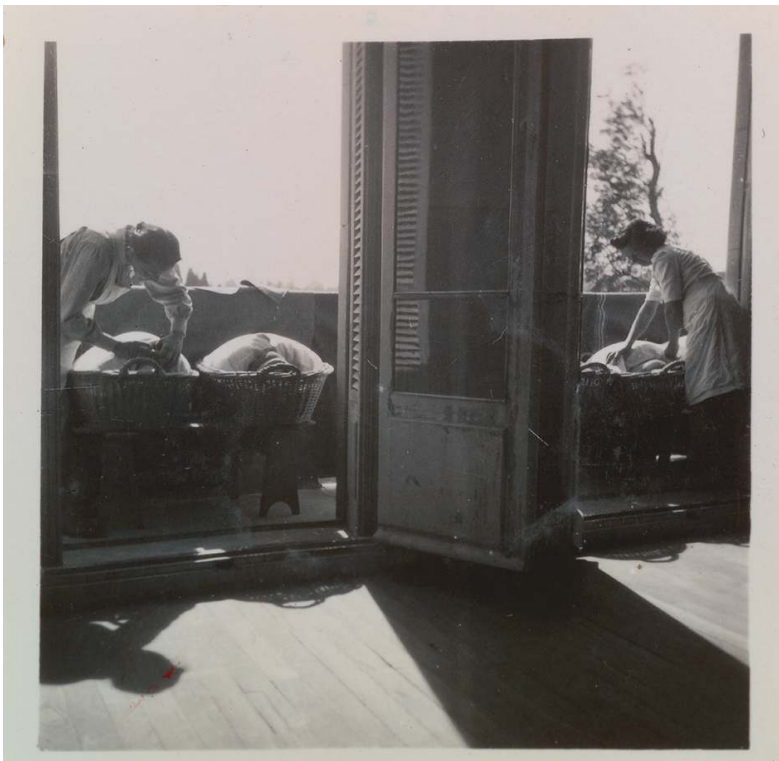
Les berceaux installés devant les fenêtres au sud : utiliser les bienfaits de l'ensoleillement était un des atouts de l'édifice. © É. Eidenbenz, Ville d'Elne.
