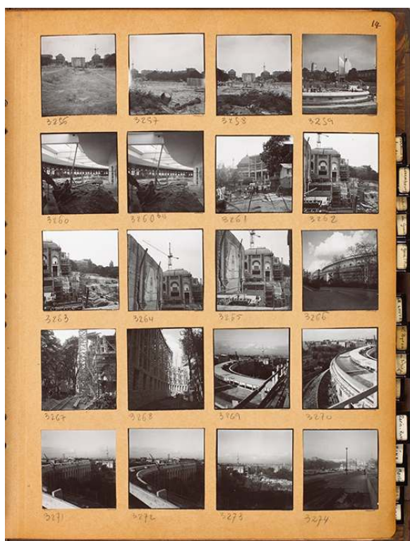
Chantiers de l'Exposition de 1937, palais du Trocadéro. Photographie d'Emmanuel Sougez septembre 1936-mai 1937, planche de contacts 6 x 6 au gélatino-bromure d'argent, N°Inv. 80.3590.9. Phot. Benoît Chain, s.d. © Conseil départemental de l'Essonne/musée français de la Photographie.
